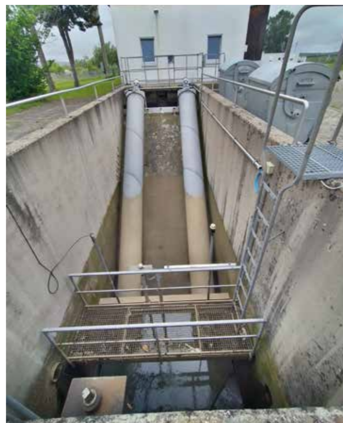
Das alte Zulaufhebewerk der Kläranlage Burgheim wird saniert. Foto: Markt Burgheim
