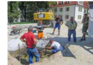
Das Fundament mit Grundplatte für den Maibaumständer wird gegossen. Allein dafür wurden 16 Kubikmeter (!) Beton verbraucht. Foto: Specht
